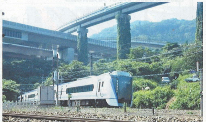
散策記「いのはなトンネル」付近
